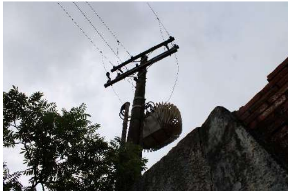
Figura 33 – Vista do poste de entrada com transformador abaixador de tensão.
