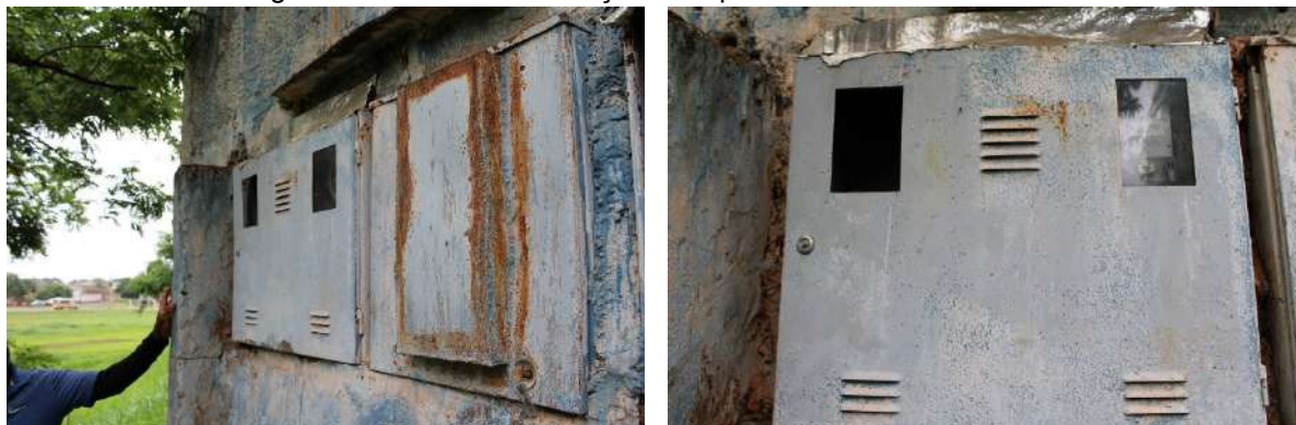
Figura 35 – Vista das condições do quadro elétrico de entrada.
