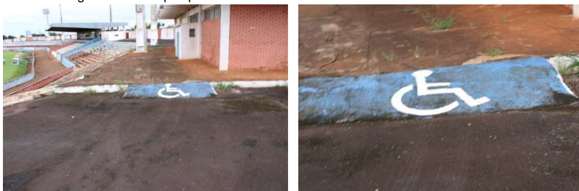
Figura 40 – Rampas para acesso de cadeirantes as áreas de bar e sanitários.
