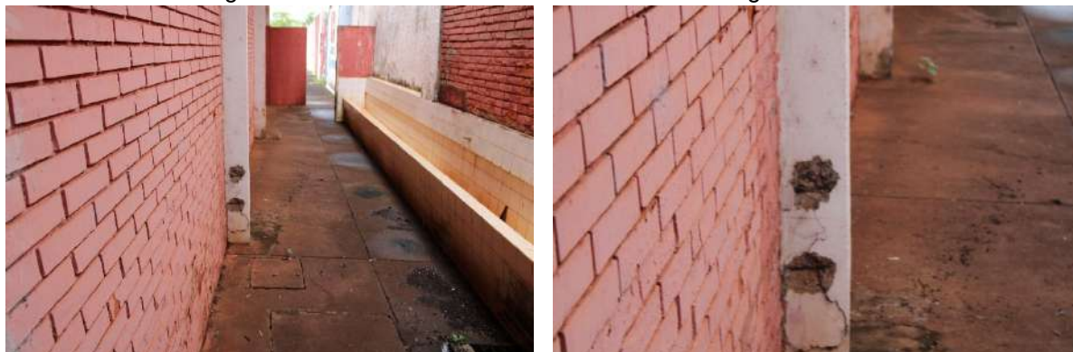
Figura 14 – Pontos de corrosão de armadura na região do bar.
