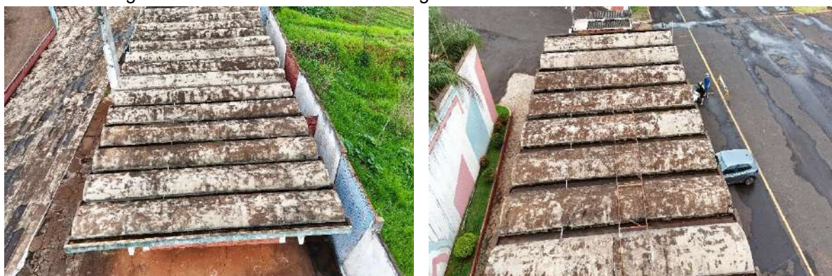
Figura 15 – Vista das calhas com irregularidades no sistema de cobertura.
