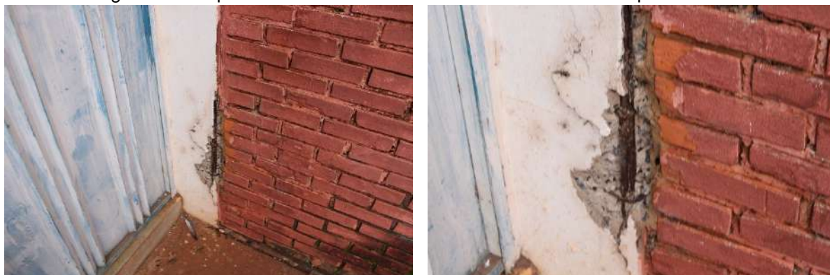
Figura 12 – Aspecto da corrosão de armadura observada em um pilar interno.
