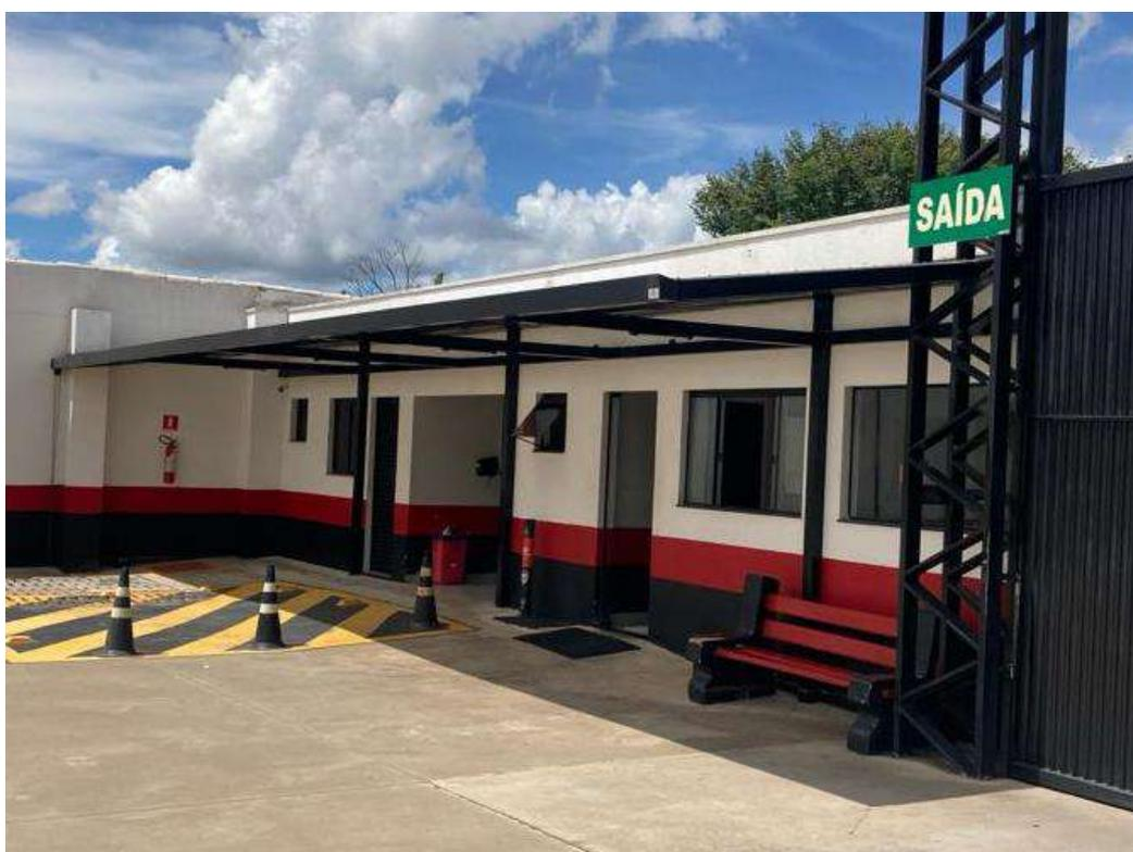
Foto 99: Portaria- estrutura em concreto armado e varanda metálica - sem sinais visíveis de desconformidade estrutural
