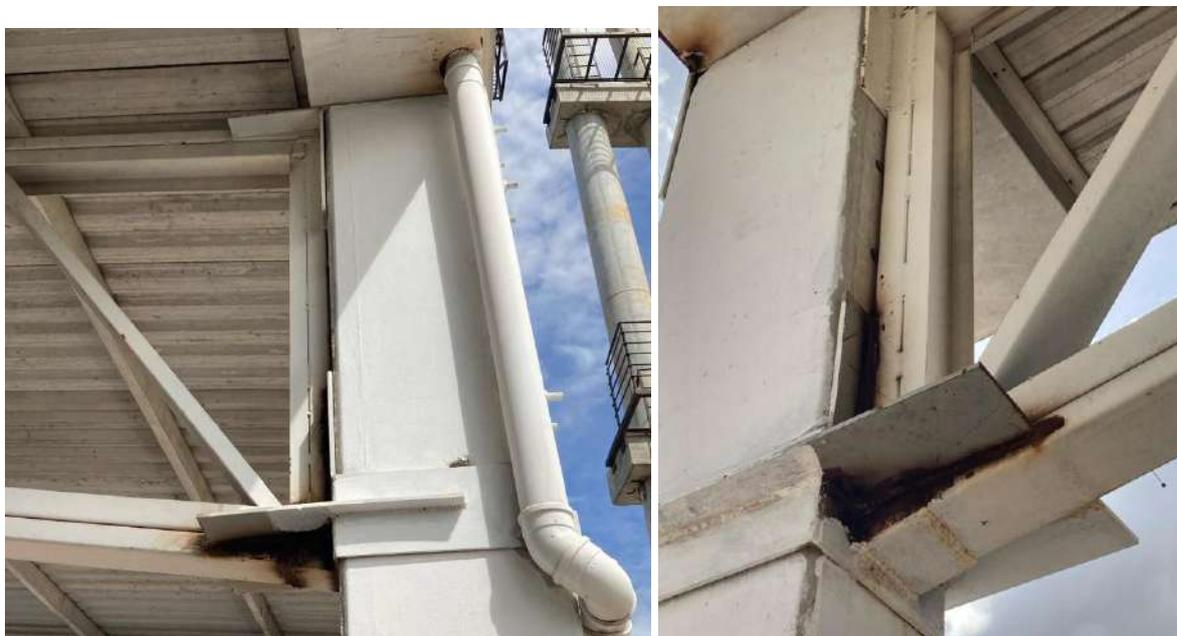
Fotos 76 e 77: Engaste das treliças 1 e 2, lado esquerdo, com necessidade de manutenção imediata
