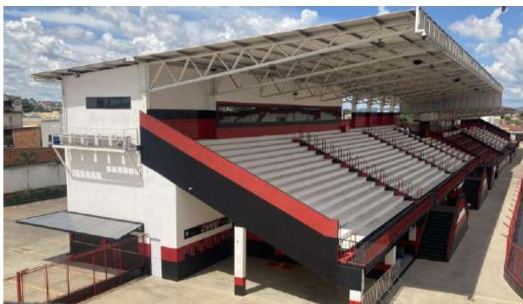
Foto 6: Lado direito do setor A – ampliação em pré-moldados de 2018 a 2020.
