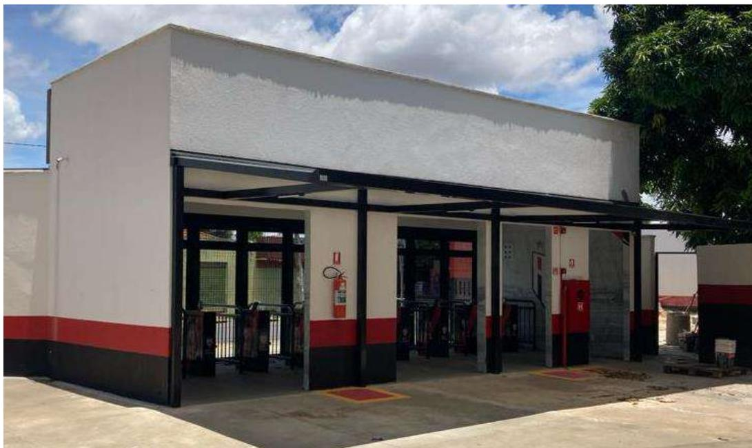
Foto 117: Estrutura em concreto e varanda metálica - sem sinais visíveis de desconformidade estrutural
