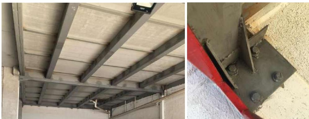
Fotos 41 e 42: Estrutura do piso dos camarotes / fixação na estrutura das arquibancadas
