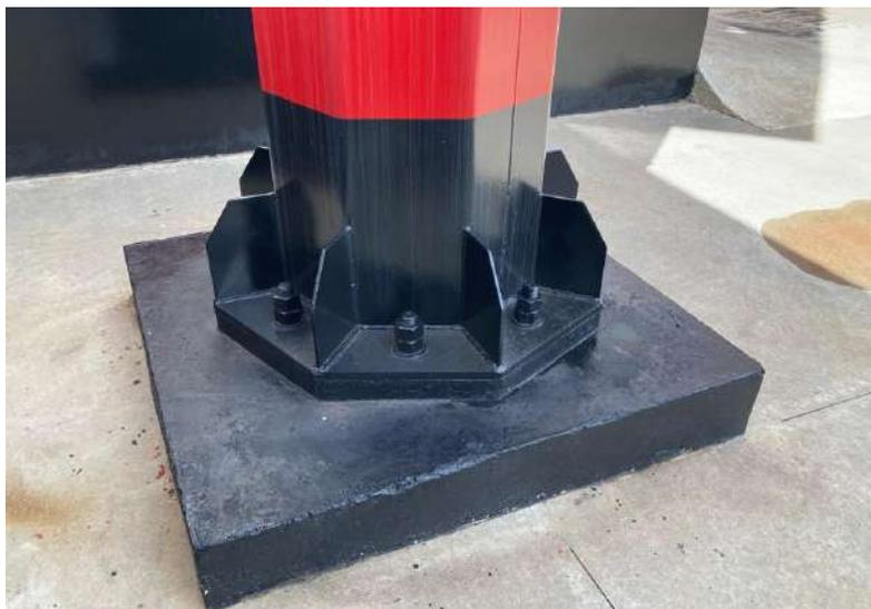
Foto 115: Base do totem do telão - Ausência de sinais de recalque de fundação
