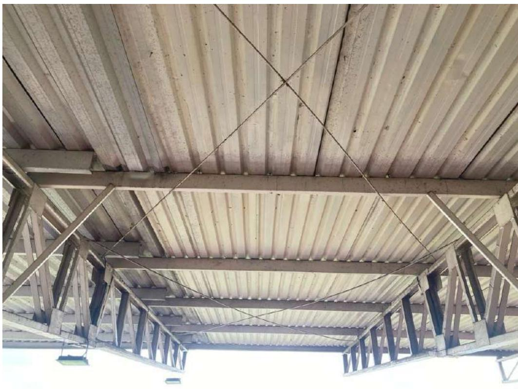
Foto 38: Tirantes da cobertura da Tribuna deformados, necessitando serem tensionados novamente
