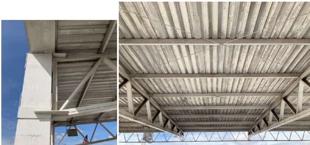
Fotos 94 e 95: Cobertura metálica em bom estado de conservação / Tirantes aparentemente tensionados
