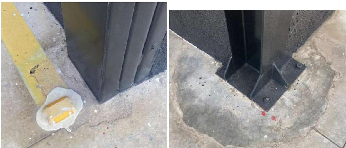
Fotos 43 e 44: Marcas de acabamento do piso sobre as placas de base metálicas
