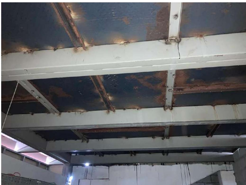
Foto 52: Estrutura dos pisos metálicos com peças e soldas sem pintura
