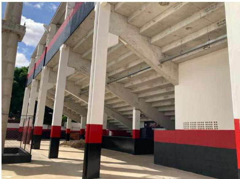
Foto 67: Estrutura pré-moldada quase toda aparente
