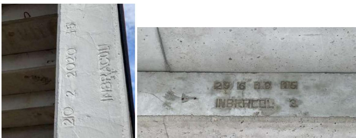
Fotos 80 e 81: Estrutura pré-moldada com datação gravada nas peças – 2018 e 2020
