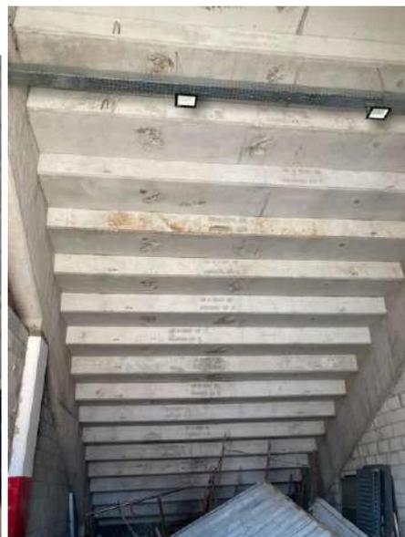
Fotos 68 e 69: Depósitos – lado direito – alvenaria estrutural e concreto aparente em bom estado
