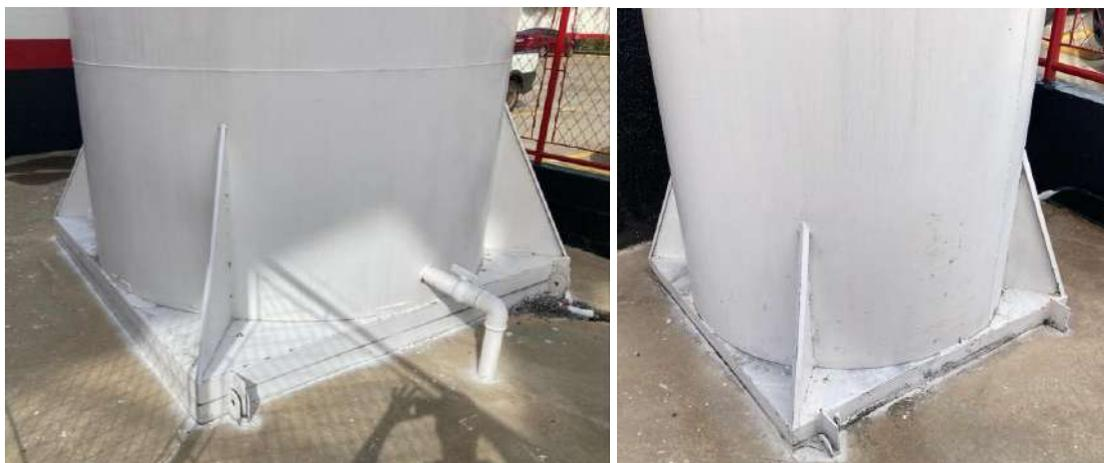
Fotos 101 e 102: Ausência de sinais de recalque de fundação
