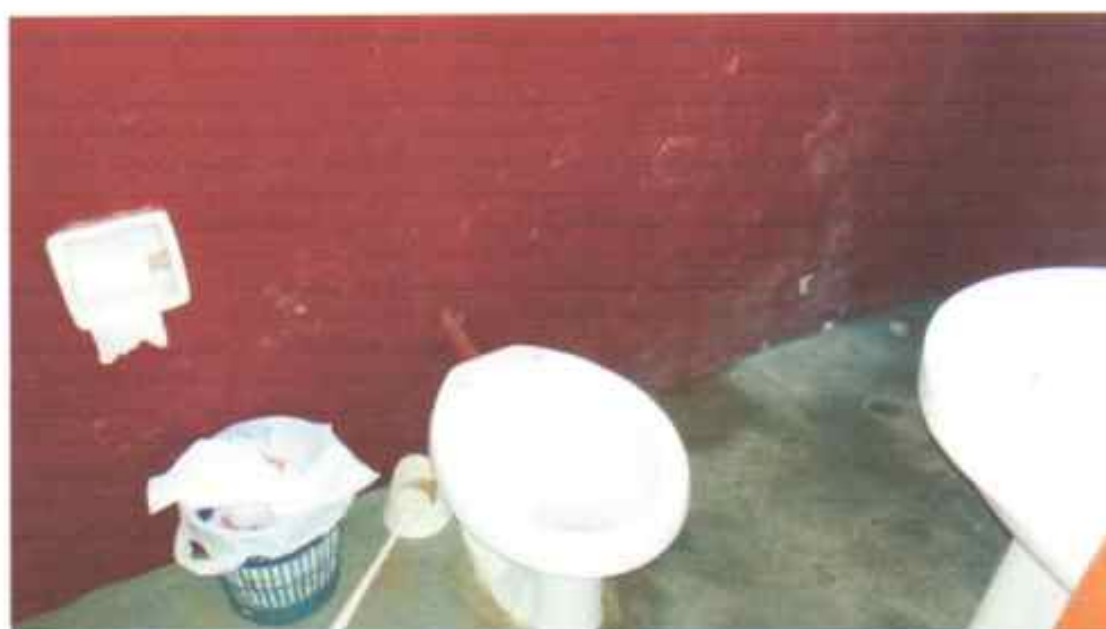
FOTO 14 – BANHEIRO DO VESTIÁRIO DOS ÁRBITROS
