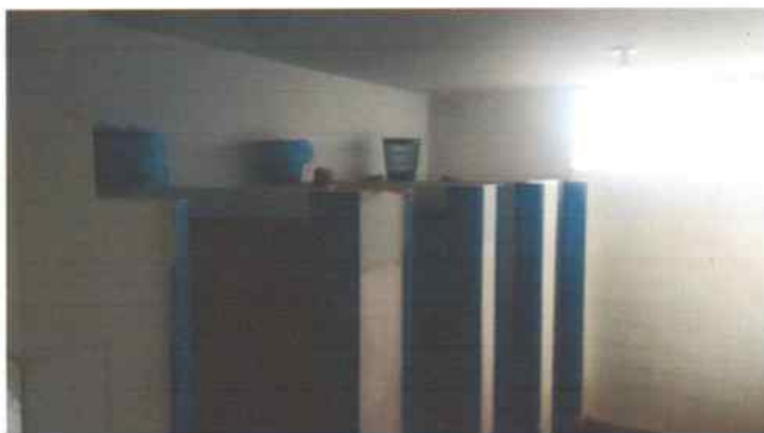
FOTO 4 – BANHEIROS DO VESTIÁRIO DO INHUMAS
