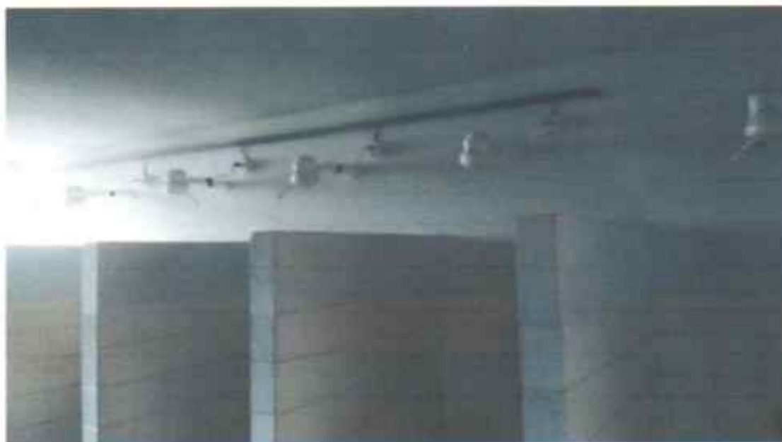
FOTO 3 – CHUVEIROS DO VESTIÁRIO DO INHUMAS
