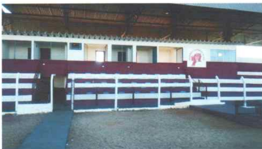
FOTO 18 – CABINES DE RÁDIO DO ESTÁDIO
