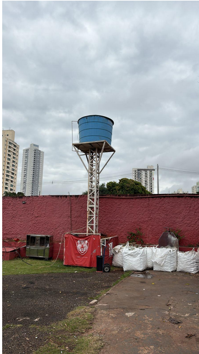
Figura 34: Reservatório Setor B
