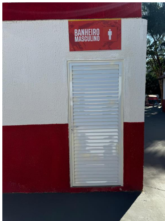
Figura 4: SANITÁRIO MASCULINO SETOR A
