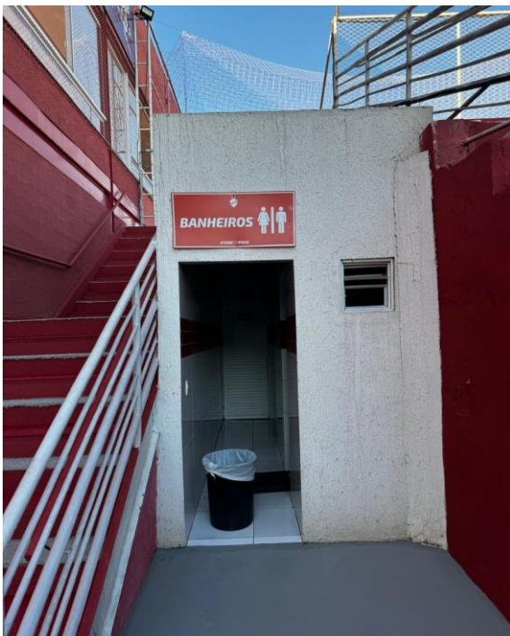
Figura 20: SANITÁRIOS SETOR C
