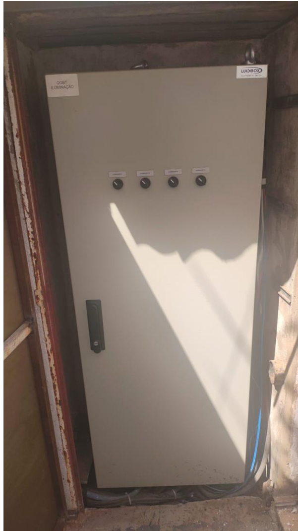
Figura 31: quadro iluminação gramado
