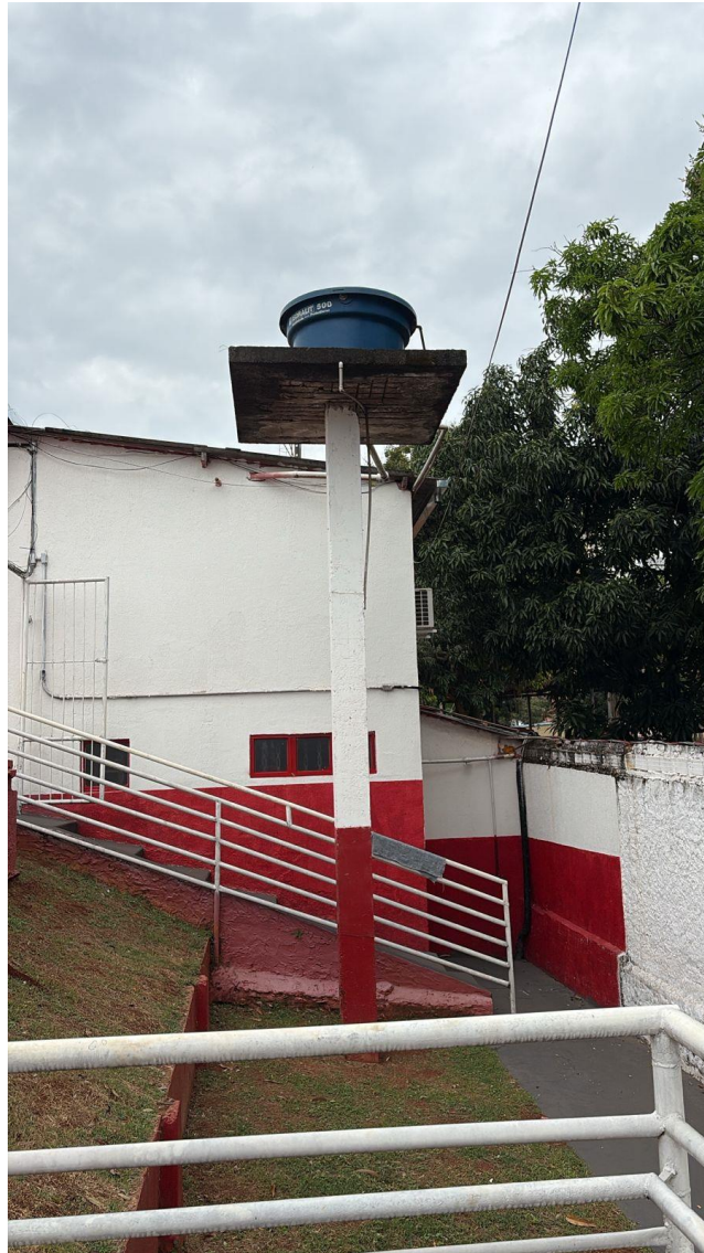
Figura 33: Reservatório Impressa e vestiários
