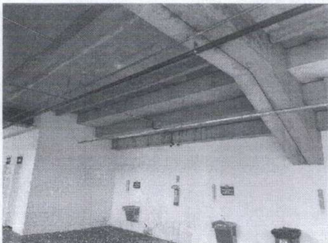
Foto 3 e 4 – Manchas de Infiltração nas vigas pré-moldadas Arquibancada Leste
