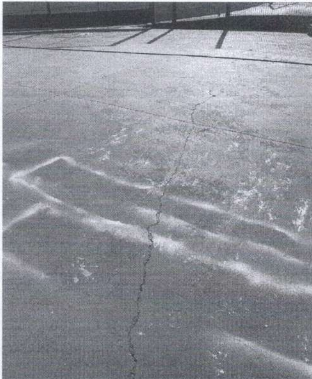
Foto 1 – Fissuras no Piso – Rampa de Acesso dos torcedores locais
