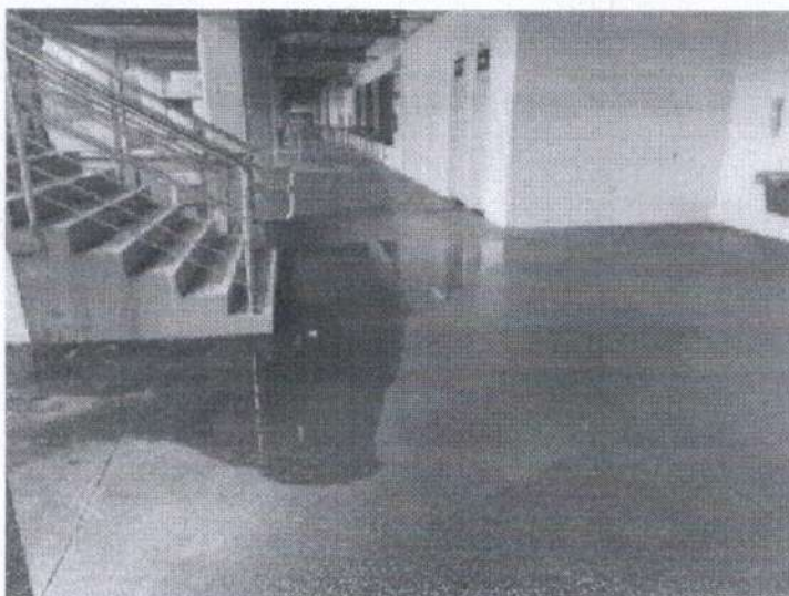
Foto 5 – Água empoçada próximo a escada da Arquibancada Leste
